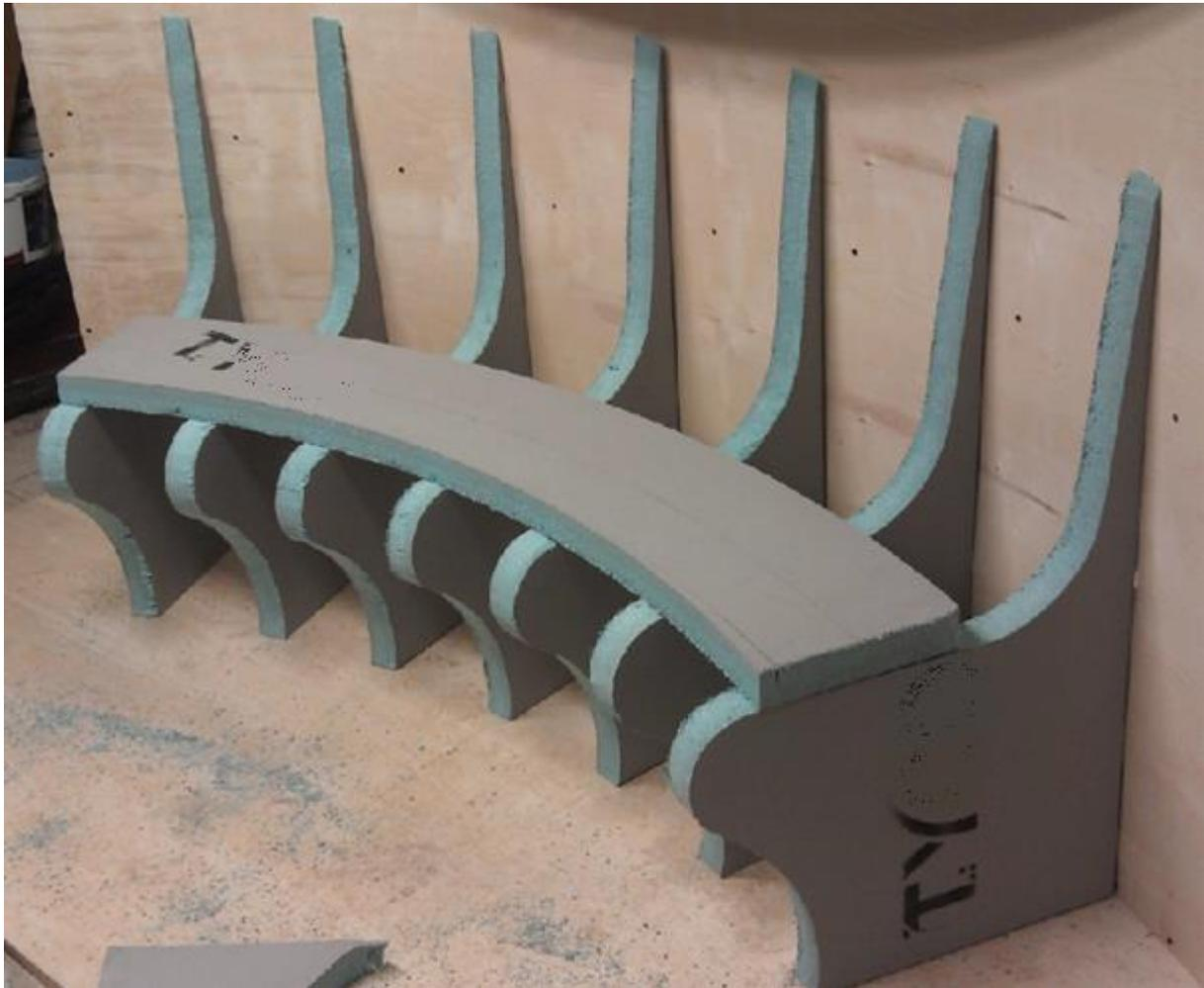
3. Im Bereich mit ebener Fläche verbinden Sie die Stützfüße mit 50 mm Tycroc TWP Bauplatte und Tycroc Premium FIX Kleb- und Dichtstoff. Ebenfalls dämmen Sie alle Fugen der Bauplatten.
