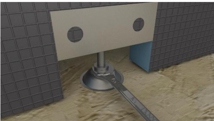
Die Badewannenverkleidung kann auch mit einstellbaren Füßen fixiert werden, indem die Verkleidung fest gegen den Wannenrand gehoben wird. Zum Einstellen eignet sich ein 13-mm-Schlüssel.
