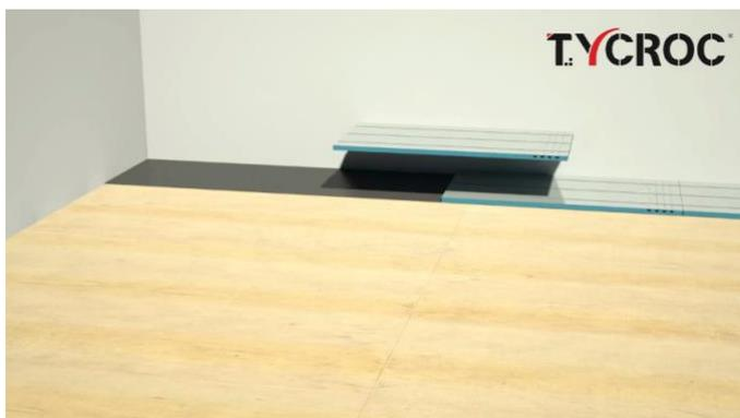
Dėkite plokštes ant mišinio / klijų ir prispauskite, kad plokštė sukibtų su pagrindu. Patikrinkite, ar plokštės ant grindų yra horizontalios (tinkamas įrankis yra plaktukas ir medinė atraminė lentelė arba kaladėlė – pakalant plokštę į vietą).
