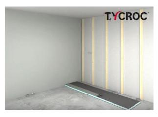
Равномерным слоем нанести на всю поверхность или на строительную плиту Тусгос TWP подходящую клеевую смесь. Прижать плиту к стене и выровнять.
