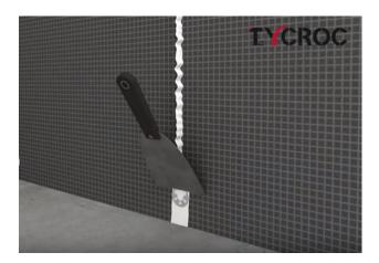
Используя шпатель изолировать кпеем-герметиком промежутки между строительными плитами, углы и другие проходы, покрыв им также металлические дюбели. В душевом углу и других углах стена / стена или стена / пол, входящих в непосредственный контакт с водой, дополнительно использовать изоляционную ленту и гидроизоляционную мастику. Для изоляции торцов труб использовать клейгерметик Tycroc Premium FIX или, если проходы слишком подходящую велики. изоляционную манжету гидроизоляционную мастику.
