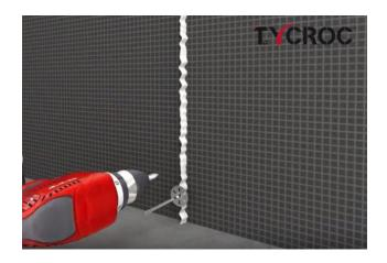
Для крепления строительной плиты Тусгос TWP на каркасе следует использовать шурупы для гипсокартона (подходящий тип шурупа зависит от каркаса) и крепежные шайбы Тусгос 36 × 0,6 мм. Используемые шурупы должны проникать в основание / каркас как минимум на 20 мм. Шурупы следует закреплять на каркасе с шагом 500 мм. При последующей отделке (шпаклевка / покраска) строительные плиты можно крепить к каркасу клеем-герметиком Тусгос Premium FIX и шурупами, не используя крепежные шайбы.
