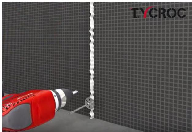
Tycroc TWP celtniecības plāksnes piestiprināšanai pie konstrukcijas jāizmanto Tycroc skrūves M4x35 mm vai M4x55 mm un 36x0,6 mm Tycroc stiprinājuma paplāksni. Izmantojiet skrūves, kuras var iedzīt pamatvīsmā/ karkasā vismaz 20 mm dzījumā. Attālumam starp skrūvēm uz karkasa ir jābūt 500 mm. Turpmākās špaktelēšanas/ krāsošanas gadījumā celtniecības plāksnes var piestiprināt karkasam ar Tycroc Premium FIX līmes-hermētiķi un skrūvēm, neizmantojot paplāksnes.
