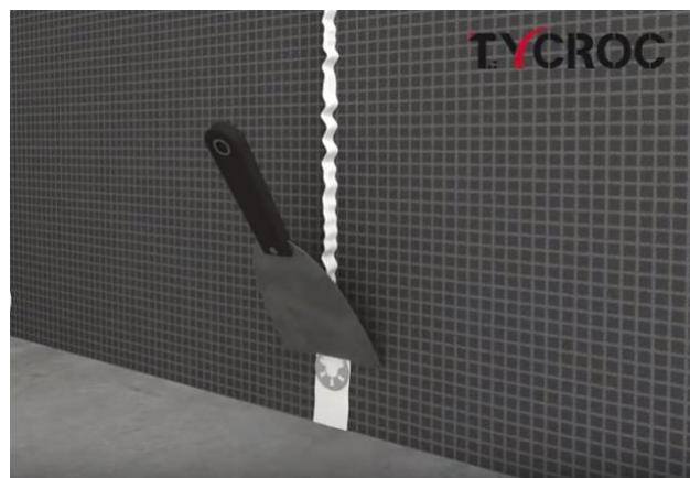
Используя шпатель, изолировать kleem-герметиком промежутки между строительными плитами, углы и другие проходы, покрыв им также металлические дюбели. В душевом углу и других углах стена / стена или стена / пол, входящих в непосредственный контакт с водой, дополнительно использовать изоляционную ленту и гидроизоляционную мастику. Для изоляции торцов труб использовать клей-герметик Tycroc Premium Fix или, если проходы слишком велики, подходящую изоляционную манжету и гидроизоляционную мастику.
