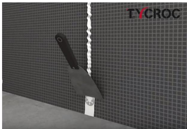
Используя шпатель, изолировать клеем-герметиком промежутки между строительными плитами, углы и другие проходы, покрыв им также крепежные шайбы. В душевом углу и других углах стена / стена или стена / пол, входящих в непосредственный контакт с водой, дополнительно использовать изоляционную ленту и гидроизоляционную мастику.
