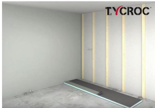
Равномерным слоем нанести на всю поверхность или на строительную плиту Тускос TWP подходящую клеевую смесь. Прижать плиту к стене и выровнять.
