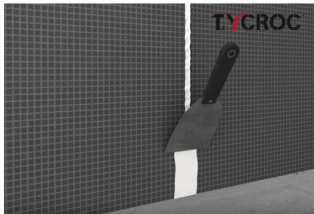
Используя шпатель, изолировать kleem-герметиком промежутки между строительными плитами, углы и другие проходы, покрыв им также крепежные шайбы. В душевом углу и других углах стена / стена или стена / пол, входящих в непосредственный контакт с водой, дополнительно использовать изоляционную ленту и гидроизоляционную мастику. Для изоляции торцов труб использовать клей-герметик Тускос Premium Fix или, если проходы слишком велики, подходящую изоляционную манжету и гидроизоляционную мастику.
