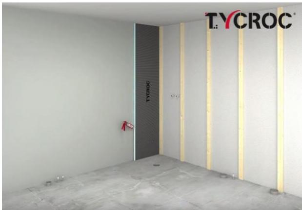
Перед установкой следующей плиты нанести на край предыдущей плиты клей-герметик Тускос Premium Fix, чтобы склеить строительные плиты между собой.
