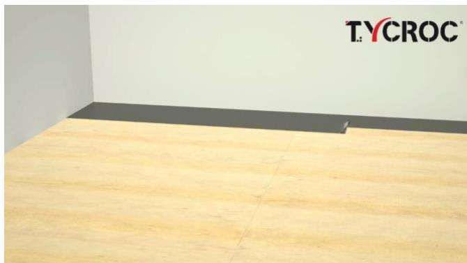
Uzstādot Tycroc UHP grīdas apkures pamatplāksnes, pamatvirsmai ir jābūt līdzenei, sausai, stingrai, cietai un stabilai. Tāpat tai ir jābūt attīrītai no netīrumiem, eļļas un citām smērvielām, kā arī tā nedrīkst būt sasalusi. Ar līmēšanas kemmiņi, uzklājiet flīzēšanas masu/ līmes hermētiķi uz pamatvirsmas (lai nodrošinātu labāku saķeri, pirms tam uz virsmas uzklājiet flīzēšanas masai piemērotu saķeres dispersiju).
