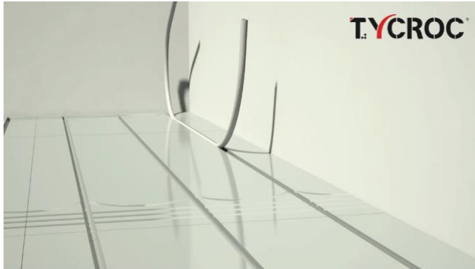
Varmista putken riittävä pituus ja paina jalalla tai kädellä lattialämmityspotki uraan.
