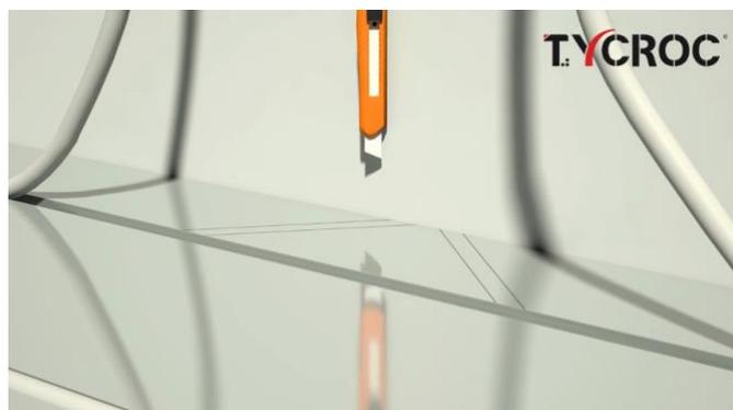
Прорезка нового канала. С помощью складного ножа или ручной фрезы прорезать желаемое новое место прохождения трубы и наклеить на дно канала алюминиевую клейкую ленту (следить, чтобы радиус изгиба нигде не был меньше 90 мм).
