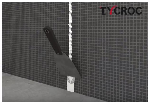
Hermetiniai klijai glaisto mentele izoliuokite statybinių plokščių sandūras, kampus ir kitas įvories bei padenkite metalinius ankerius. Dušo kampuose ar tiesiogiai visuose su vandeniu besilečiančiuose kampuose (sienos ir grindų; sienos ir sienos), naudokite izoliacine juostelę ir vandens izoliacijos mastiką. Vamzdžio galams izoliuoti naudokite Tycroc Premium Fix hermetinius klijus arba esant per didielei įvoriui - tinkamą izoliacijos antdėklą ir vandens izoliacijos mastiką.
