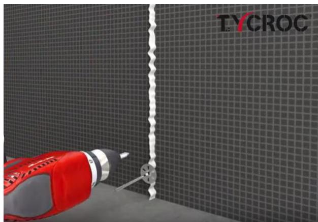
Tycroc TWP statybinių plokštėi tvirtinti ant karkaso naudokite Tycroc varžtus M4x35mm arba M4x55mm ir Tycroc tvirtinimo poveržles 36x0,6mm. Naudokite varžtus, kurie įleidžiami į pagrindą / karkasą ne mažiau kaip 20mm. Varžtai prie karkaso tvirtinami kas 500mm. Vélesnei glaisto / dažų apdailai statybinės plokštės galima prie karkaso pritvirtinti Tycroc Premium Fix hermetiniai klijai ir varžtais be poveržlių.
