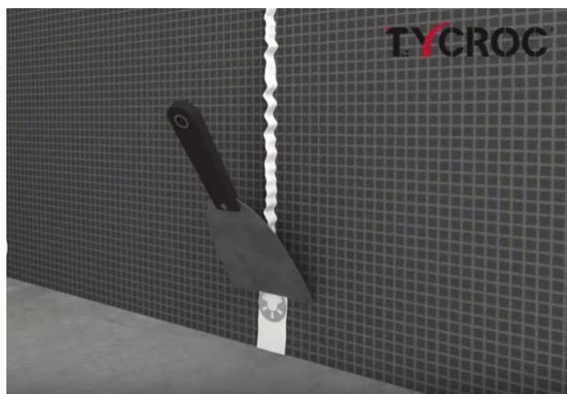
Hermetiniai klijai izoliuokite statybinių plokščių sandūras, kampus ir kitas įvorus, o taip pat padenkite ir tvirtinimo poveržles naudodami tam glaisto mentele. Dušo kampuose ar tiesiogiai visuose su vandeniu besiliečiančiuose kampuose (sienos ir grindų; sienos ir sienos), naudokite izoliacine juostelę ir vandens izoliacijos mastiką.
