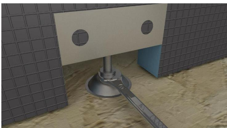
Панель для ванны можно зафиксировать с помощью регулируемых ножек, плотно притянув панель к краю ванны. Для регулировки подходит ключ на 13 мм.
