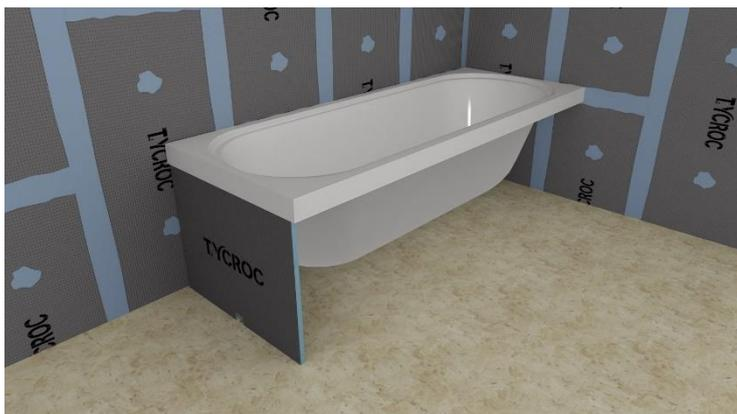
При необходимости можно отрезать панели для ванны подходящего размера. Следует убедиться, что под краем ванны остается место не только для панели для ванны Тусрос, но и для используемой в дальнейшем керамической плитки или природного камня. Нанести клей-герметик Тусрос Premium Fix на верхний край панели для ванны так, чтобы по всей длине края была непрерывная полоса клея-герметика.
