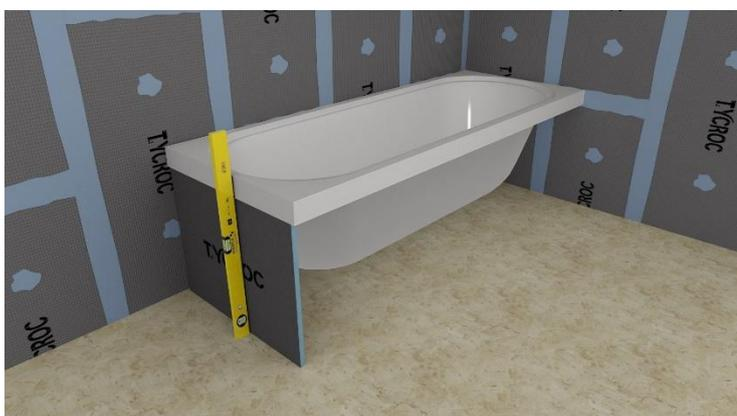
Такую же полосу клея-герметика следует нанести и на край панели, соприкасающийся с задней стеной. После этого панель нужно установить на место под краем ванны, выровнять по горизонтали и зафиксировать.
