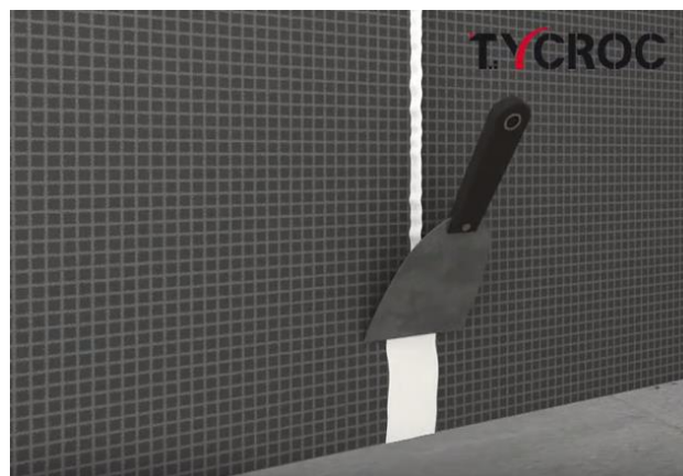
Isoleerida liimhermeetikuga ehitusplaatide vahed kohad, nurgad ja teised läbiviigid ning katta ka kinnituseibid – kasutades selleks pahtlilabidat. Dušinurgas ja mujal otseselt veega kokkupuutuvates sein / sein või sein / põrand nurkades kasutada täiendavalt isolatsioonilinti ja veetõkkemastiks. Toruotste isoleerimiseks kasutada Tycroc Premium Fix liimhermeetikut või liialt suure läbiviigu puhul sobivat isolatsioonimansetti ja veetõkkemastiks.
